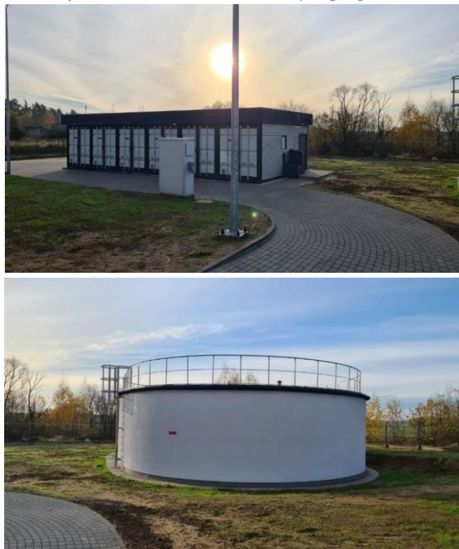
Fot. Stacja SUW w Brzozowie Starym po przebudowie.
