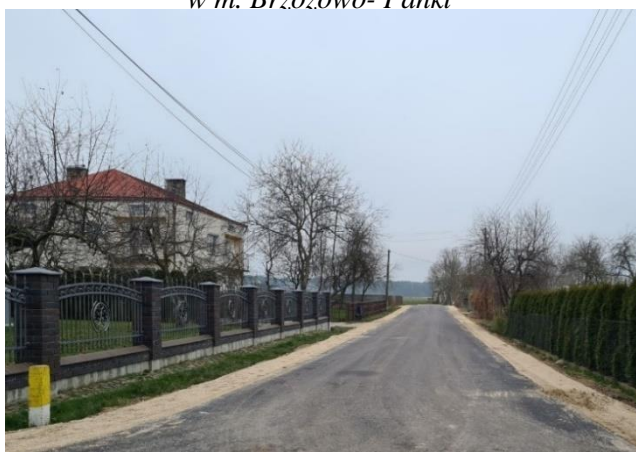
Fot. Droga po przebudowie w m. Brzozowo- Panki
