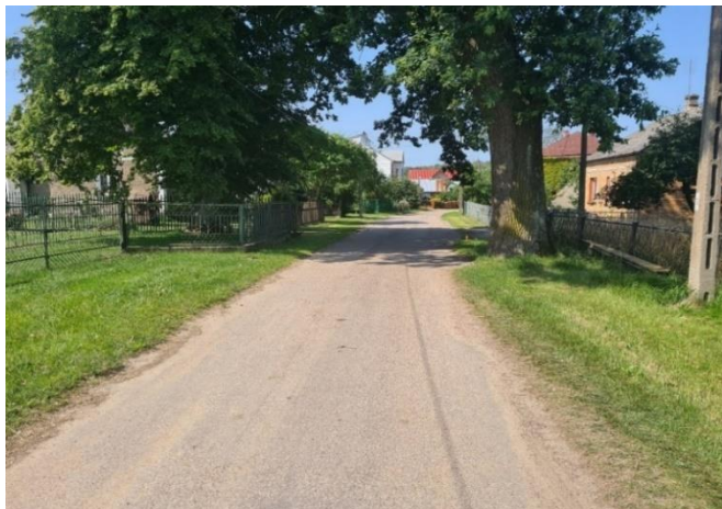
Fot. Droga przed przebudową w m. Brzozowo- Chrzczonki
