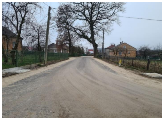
Fot. Droga po przebudowie w m. Brzozowo- Chrzczonki
