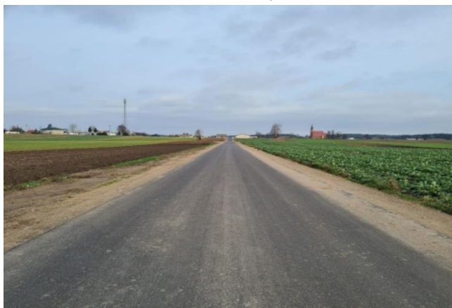
Fot. Droga przed przebudową w m. Chomizna
