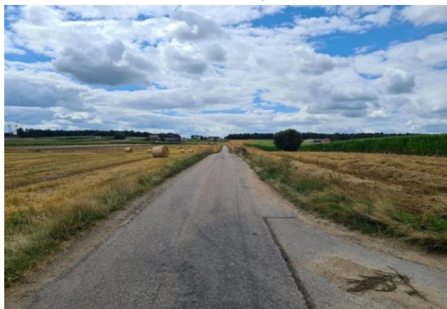
Fot. Droga przed przebudową w m. Chomizna
