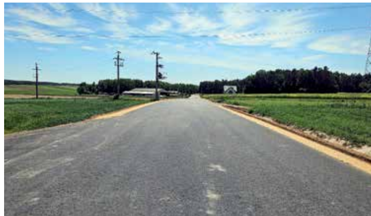
Zdjęcie drogi po przebudowie
