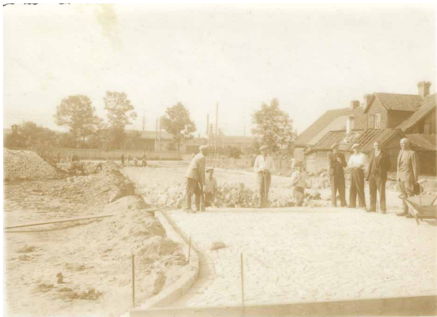
Budowa drogi w Łapach. Wśród pracowników Stanisław i Franciszek Głowaccy. Zbiory własne autora.
