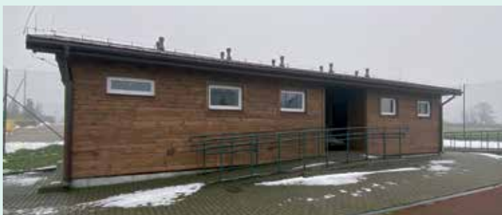
Budynek szatniowo-socjalny przy Zespole Boisk Orlik
